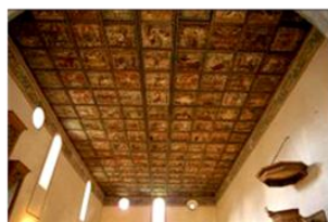
Holzbilderdecke der Kirch St. Martin in Zillis
